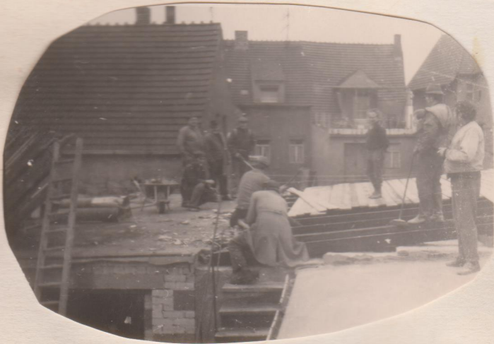
Die neue Dachhaut wird verlegt
