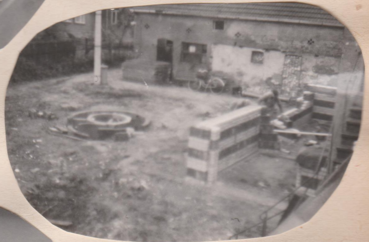
Die ersten Mauern stehen
