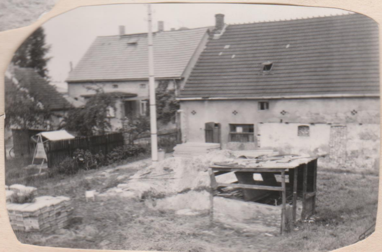
25.7.74 Die Elemente für die Kläranlage sind zu sehen
