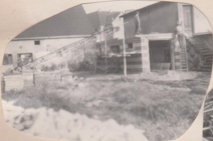
2. bis 4.11.74 Hohlblechen auflegen und Beton aufbringen
