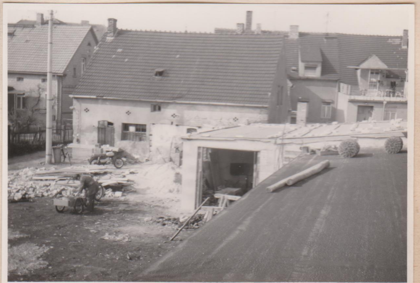
Die Elektriker sind da
