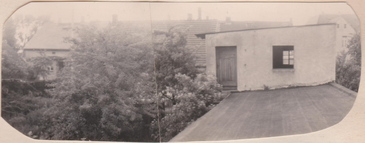
8.4.1974 Ansicht von der Bahn aus, eine Wildnis
