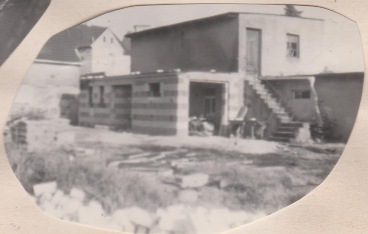
Endlich ist der Beton abgedeckt
