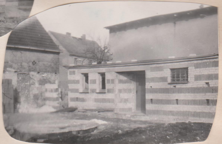
Die Kläranlage ist abgedeckt
