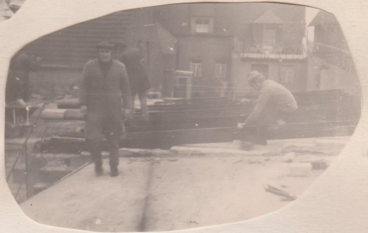
Die neuen Balken liegen schon
