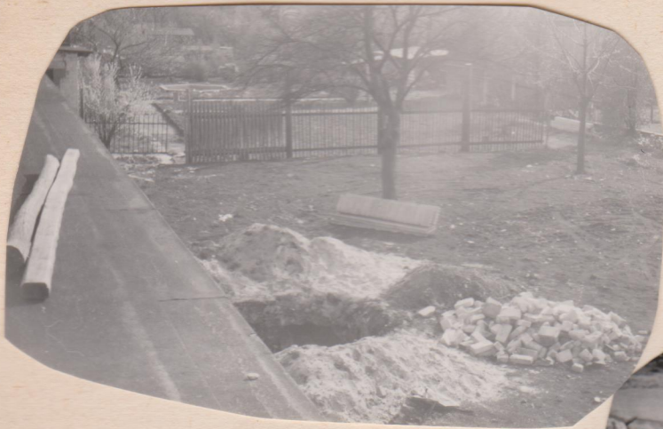
Sicker für Regenwasser
