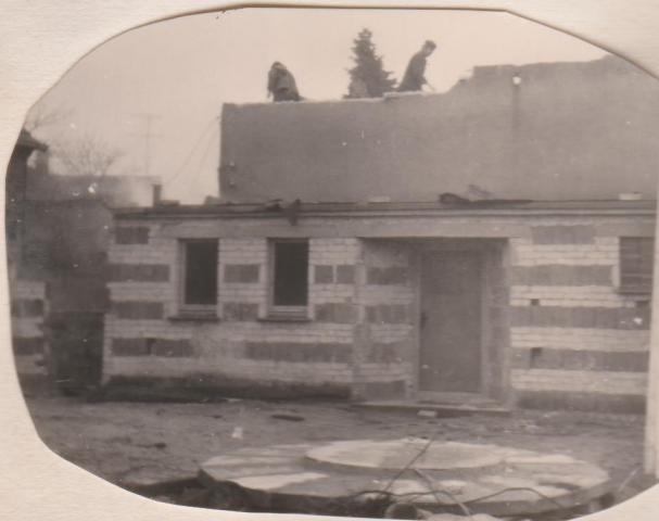
Die neue Dachhaut liegt bereit
