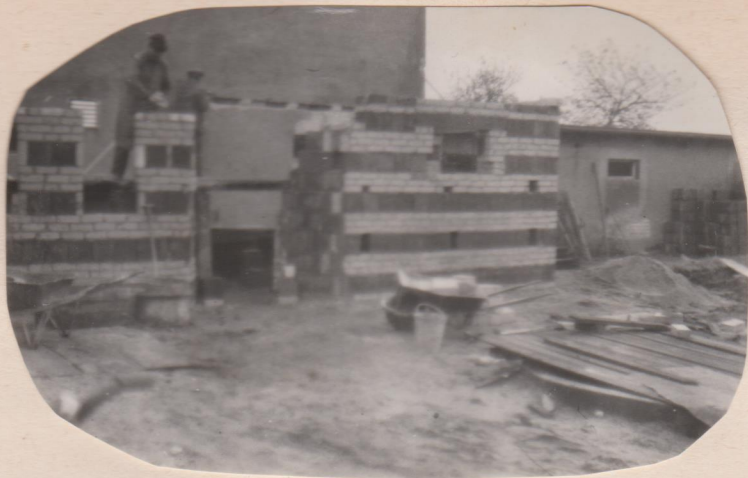
Der Kehlunker ist bis auf seine Sollhöhe gemauert Ende Oktober 1974
