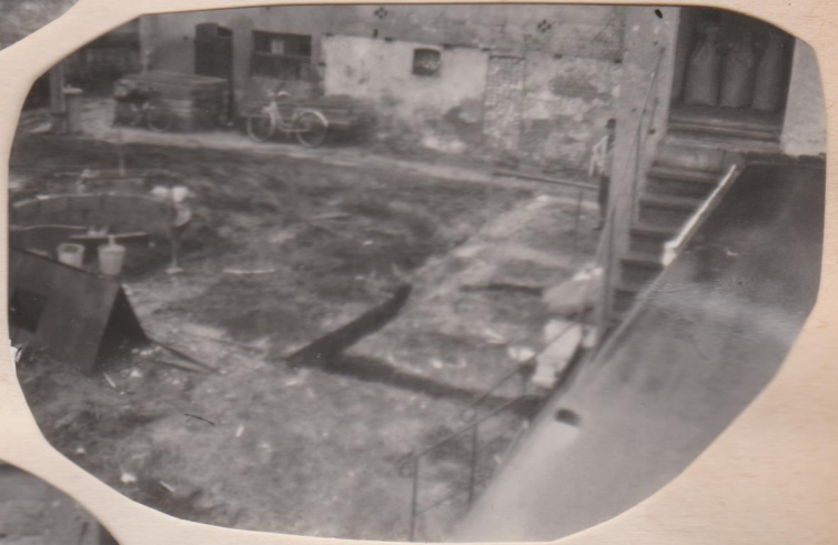
Der Außenring der Kläranlage steht, die Fundamente sind noch nicht fertig
