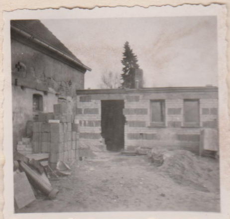
Das Dach für den Umkleideraum Liegt
