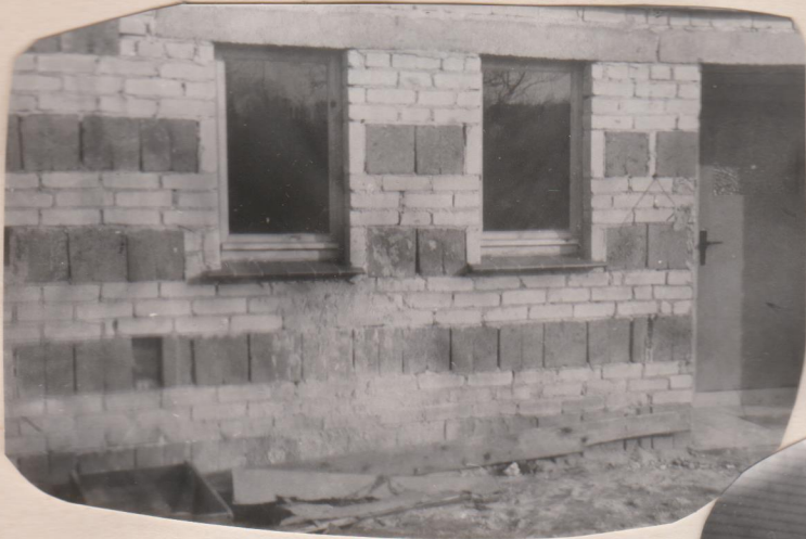
Die Toilettenfenster und die Eingangs- tür ist eingesetzt. 23.11.74
