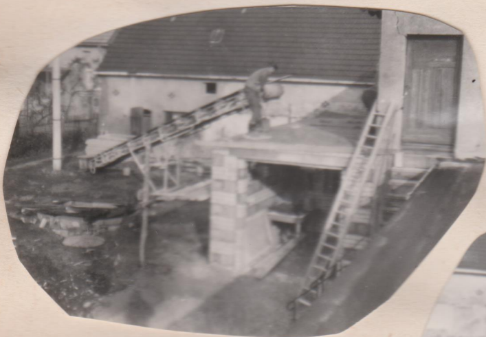
Die letzten Arbeiten am Dach, hoffentlich kommt kein Frost
