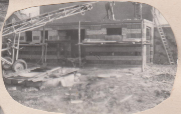
Das Dach ist fast fertig, die Kläranlage ist mit Brettern abgedeckt
