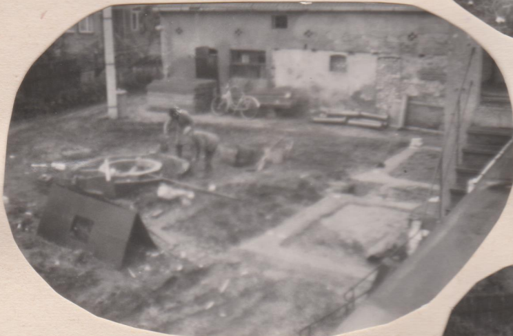
Die Innenwände der Kläranlage sind fertig, die neuen Fundamente liegen
