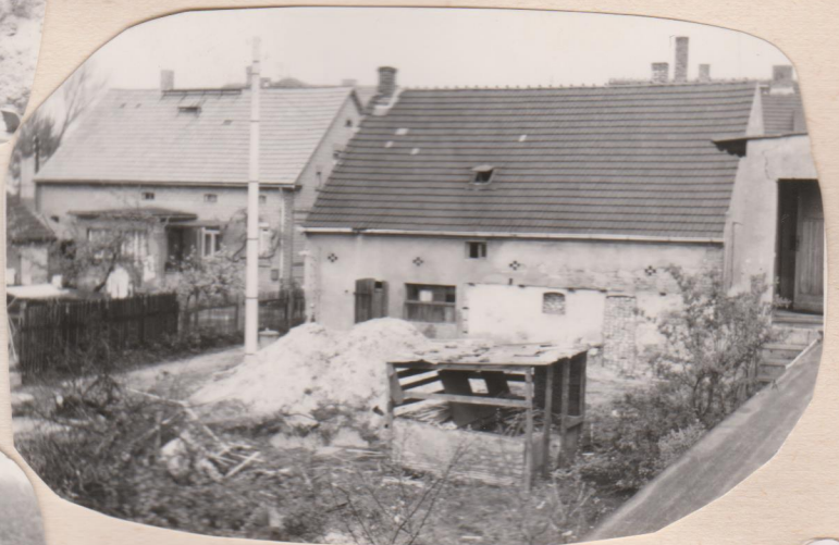
13.4.74 Kläranlage und Kohleschuppen
